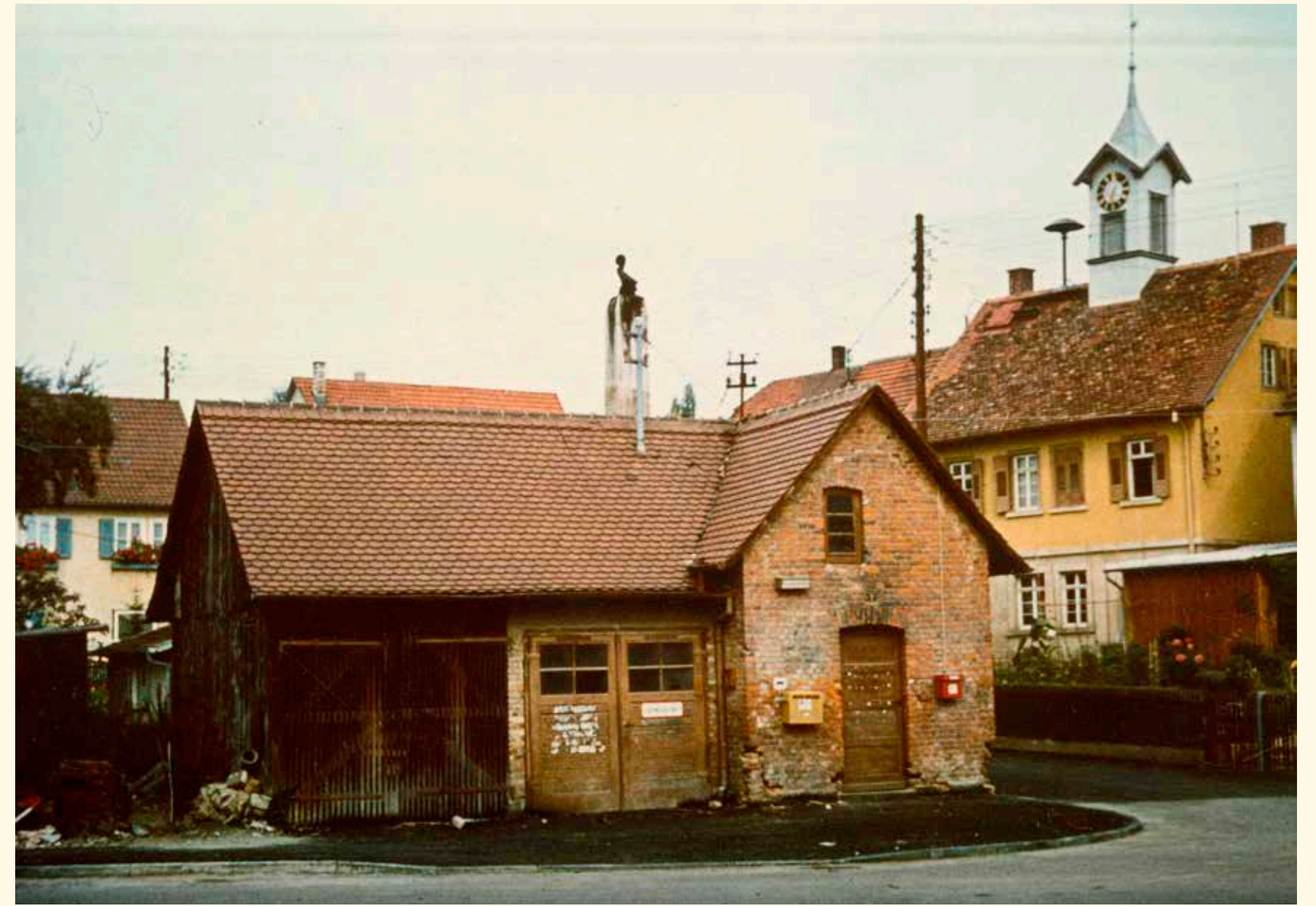
Backhaus und Schulhaus, Aufnahme 1950er Jahre
