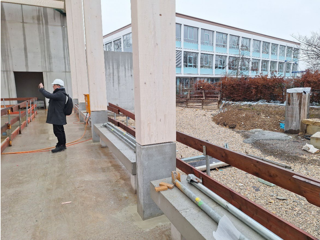
Februar 2026, Stützen Lehrschwimmhalle
