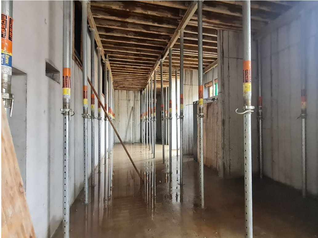
Anfang August 2025, Fertigstellung Betonage Decke über UG
