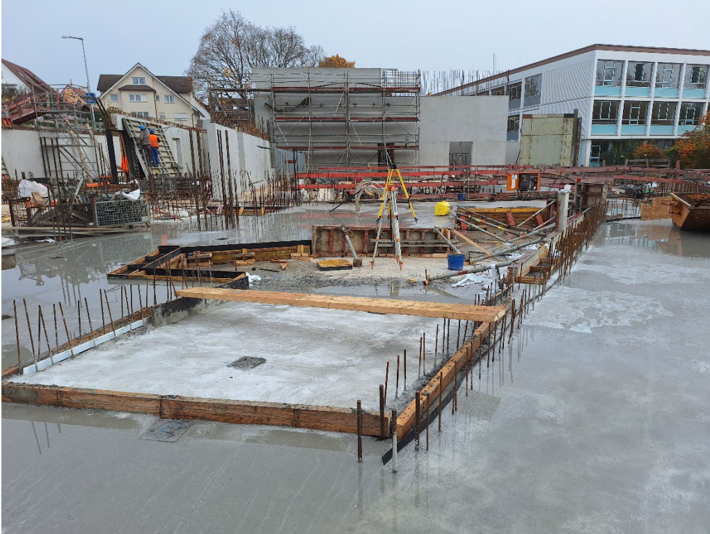
Oktober 2025, Betonage Kinderbecken
