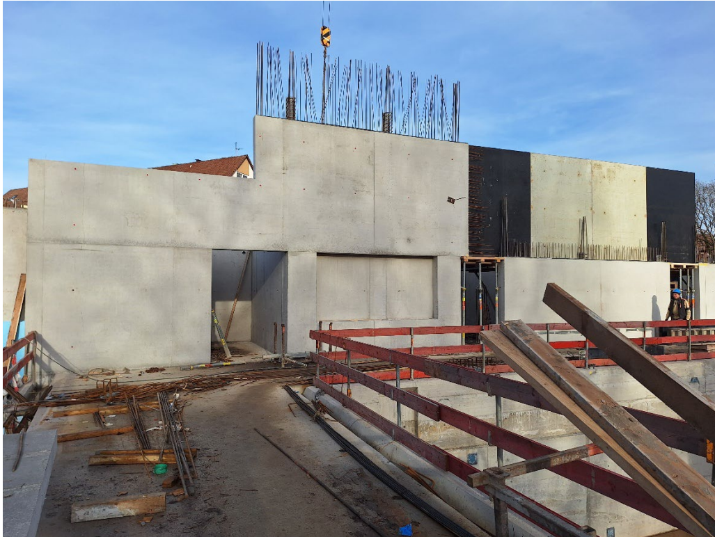
November 2025, Betonage OG Wände
