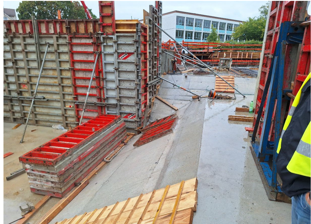
September 2025, Betonage Schwimmerbecken
