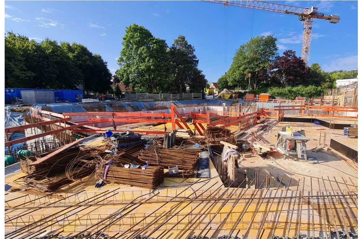
Mitte August 2025, Schalungsarbeiten Kinderbecken
