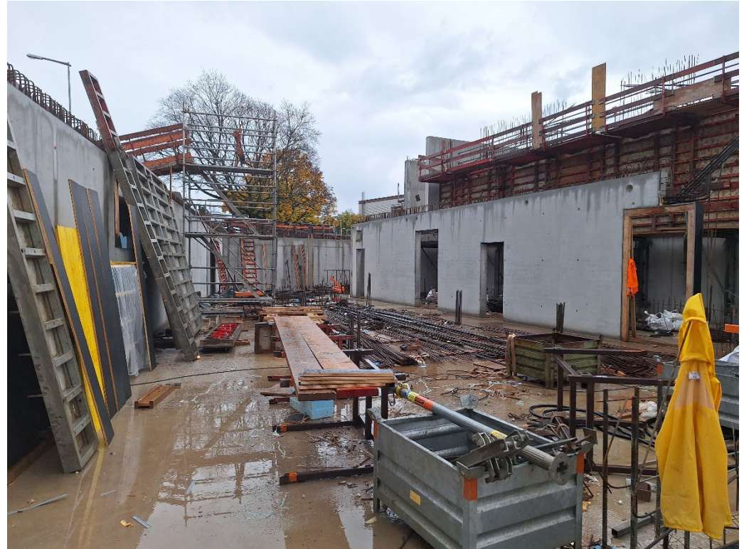
Oktober 2025, Betonage EG Wände (Umkleiden)
