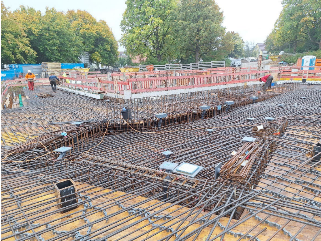
Oktober 2025, Bewehrung Kinderbecken
