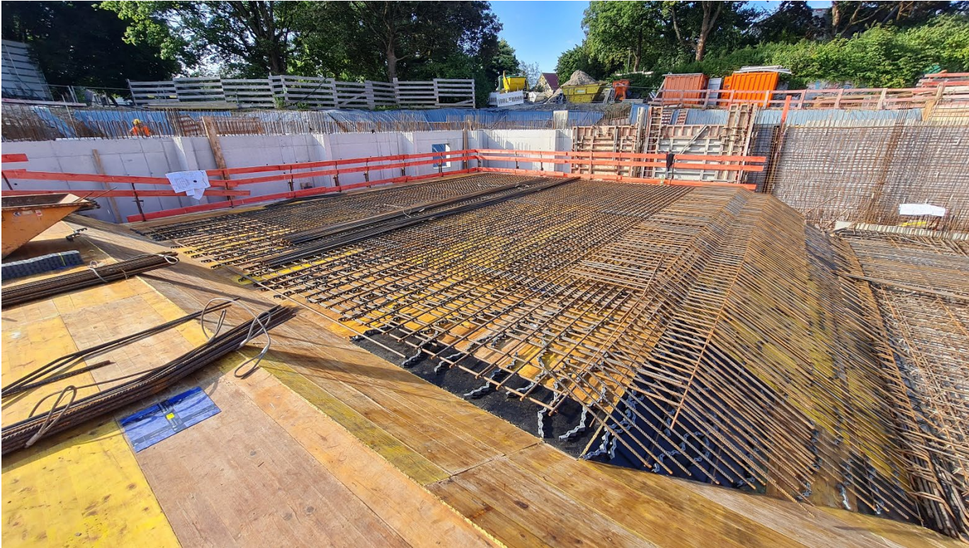
August 2025, Bewehrung Schwimmerbecken
