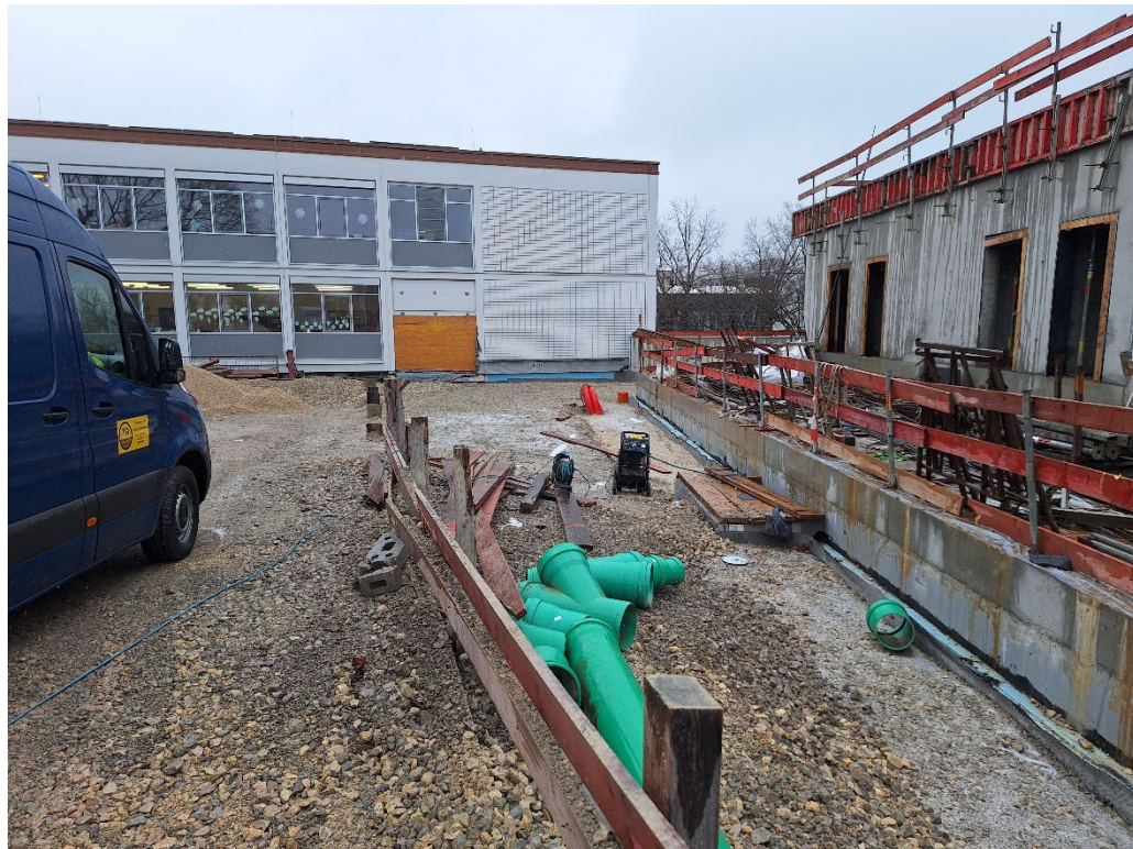
Januar 2026, Leitungen zwischen LUS- HBLE abgeschlossen, verfüllt
