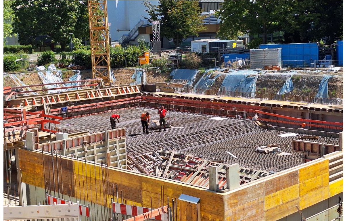
Ende August 2025, Bewehrungsarbeiten Schwimmerbecken
