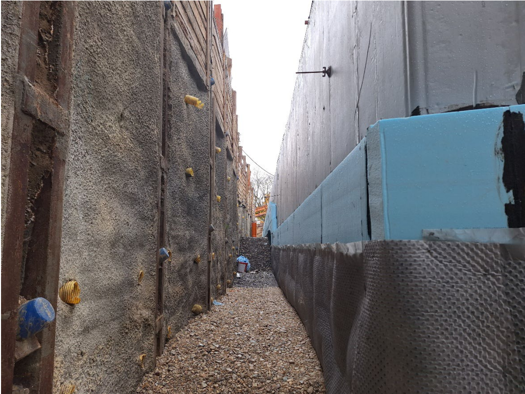
Oktober 2025, Verfüllarbeiten zw. Verbau und Aussenwand
