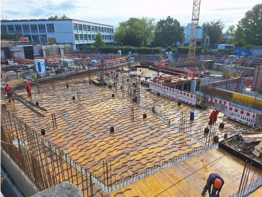
September 2025, Beginn Bewehrung Bodenplatte EG
