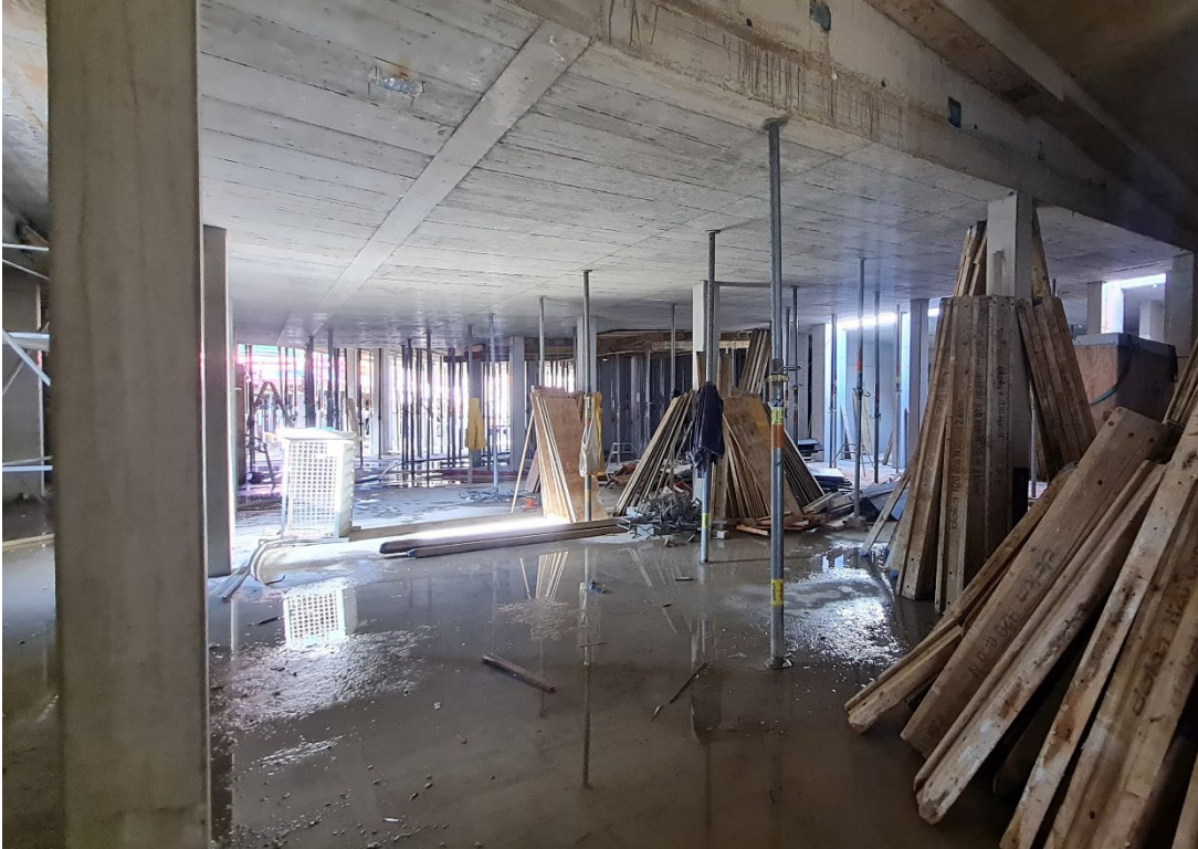
Mitte August 2025, Ausschalarbeiten Kellerräume
