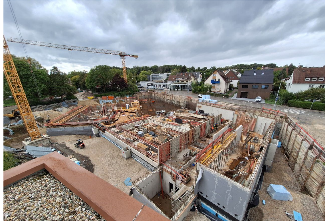
September 2025, Bewehrung Bodenplatte EG
