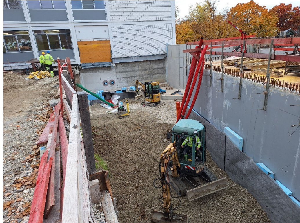
Oktober 2025, Anschlussarbeiten Ludwig-Uhland-Schule
