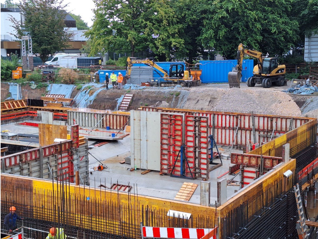
September 2025, Betonage Schwimmerbecken
