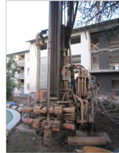
Erdsondenbohrung
