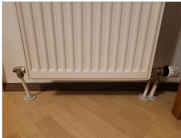
Einrohrheizkörper mit Bypass
