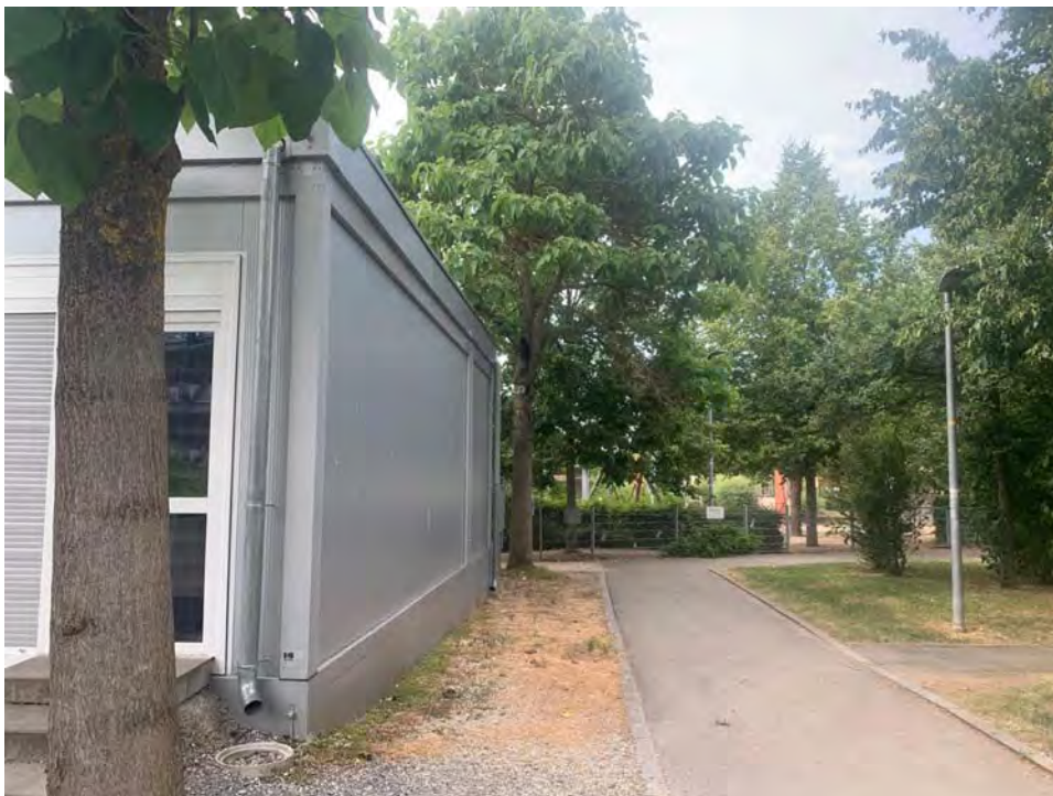
Abb. 3: Container (Ziegeleistraße 7/1), Ostfassade
