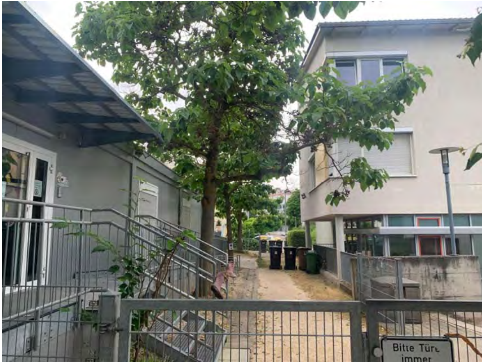
Abb. 4: Links Container (Ziegeleistraße 7/1), rechts Hauptgebäude Kindertagesstätte (Ziegeleistraße 7)
