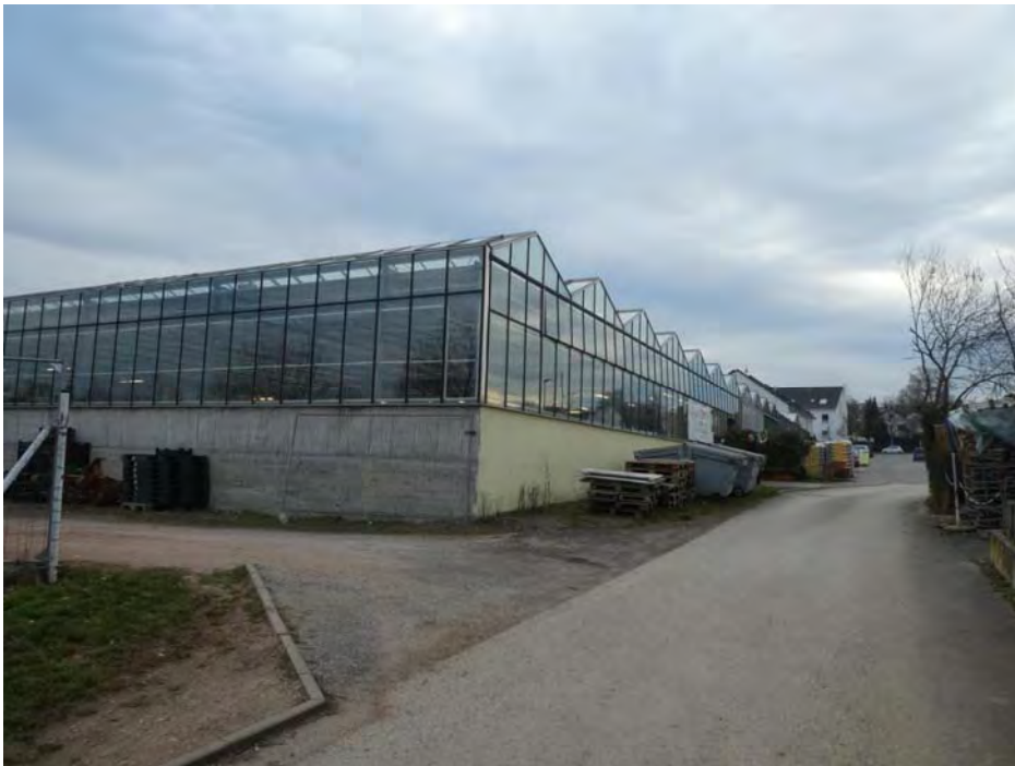
Abb. 1: Gärtnereigebäude – Blick von Nordosten
