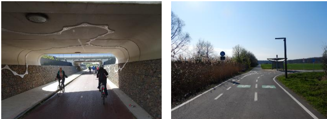
Abbildung 10: Radschnellverbindungen bei Arnheim (NL) und Frankfurt-Darmstadt (bei Egelsbach)
