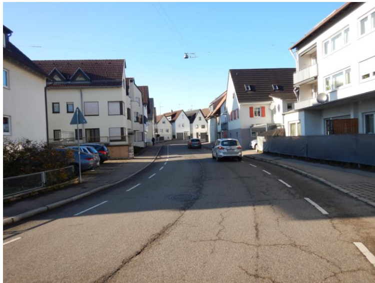
Abbildung 5: Nicht den aktuellen Standards entsprechenden Schutzstreifen in der Bonländer Straße
