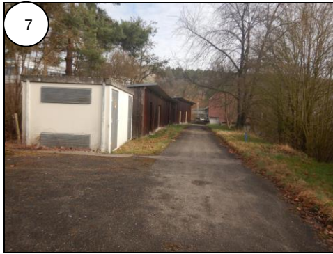
Schuppengebäude im Westen des Plangebiets
