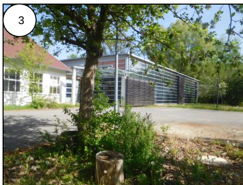
Blick auf Fabrikgebäude der Firma Haru Präzision, rechts daneben der Tümpel
