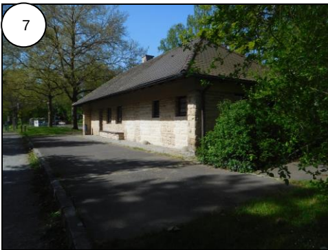
Angrenzendes altes Bahnhofs-Gebäude der ehemaligen Bahnstrecke Leinfelden – Walden- buch durch das Siebenmühlental
