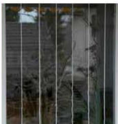
Bei Holzfenstern praktisch und günstig: Beidseitig an Rahmen je 1 Nagel einschlagen, Gummiband spannen und alle 10 cm eine dicke weisse Nylonseil anknüpfen.
