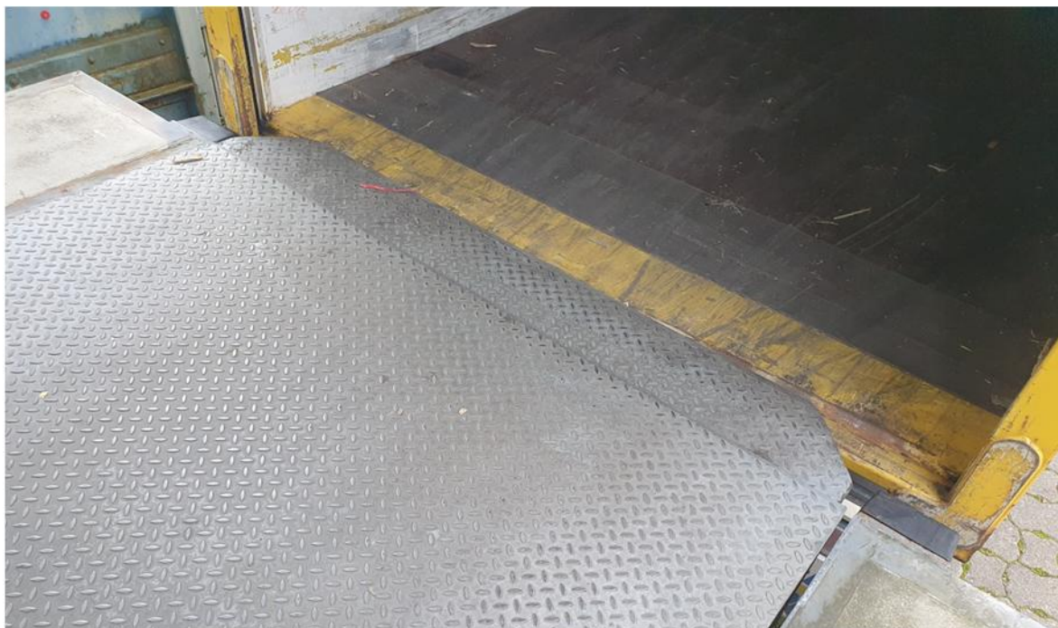
Überladesituation an der Außenrampe
