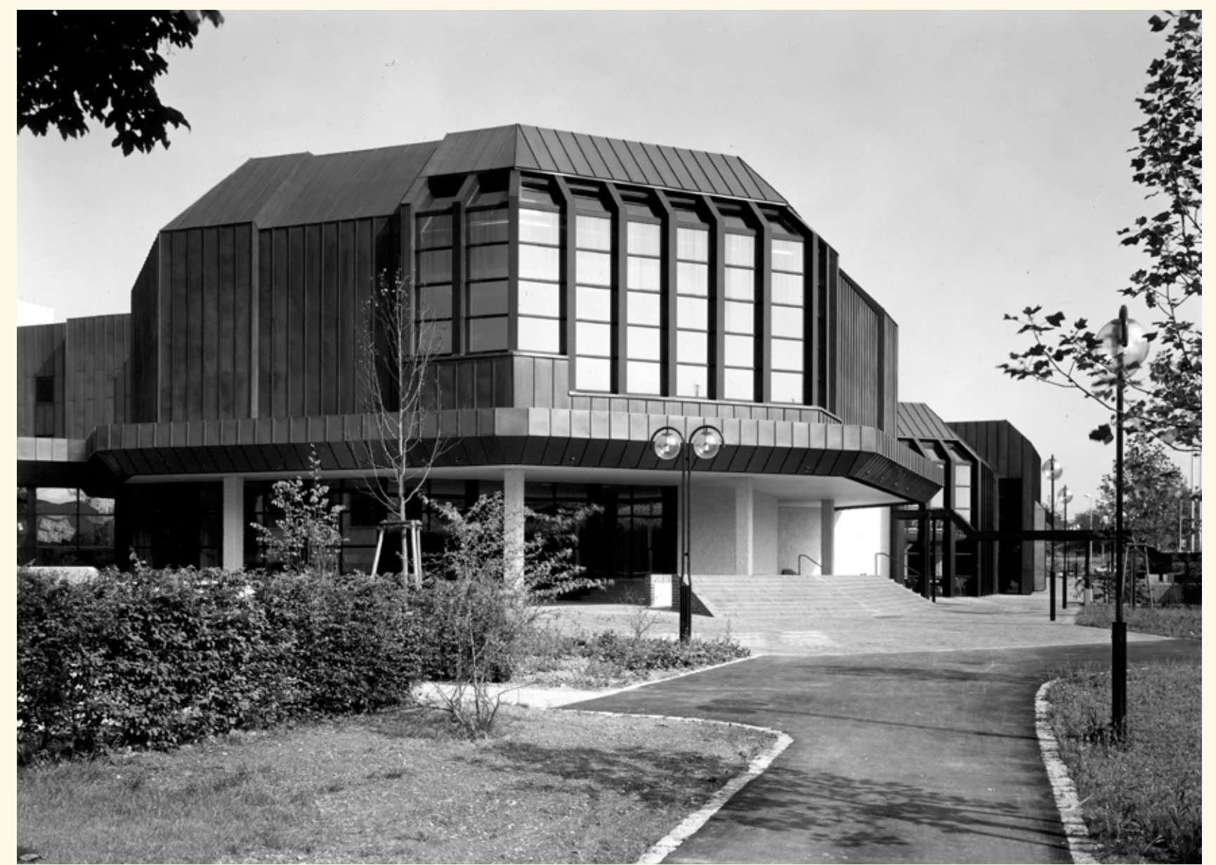
Die Filderhalle nach dem Umbau, Aufnahme 1984
