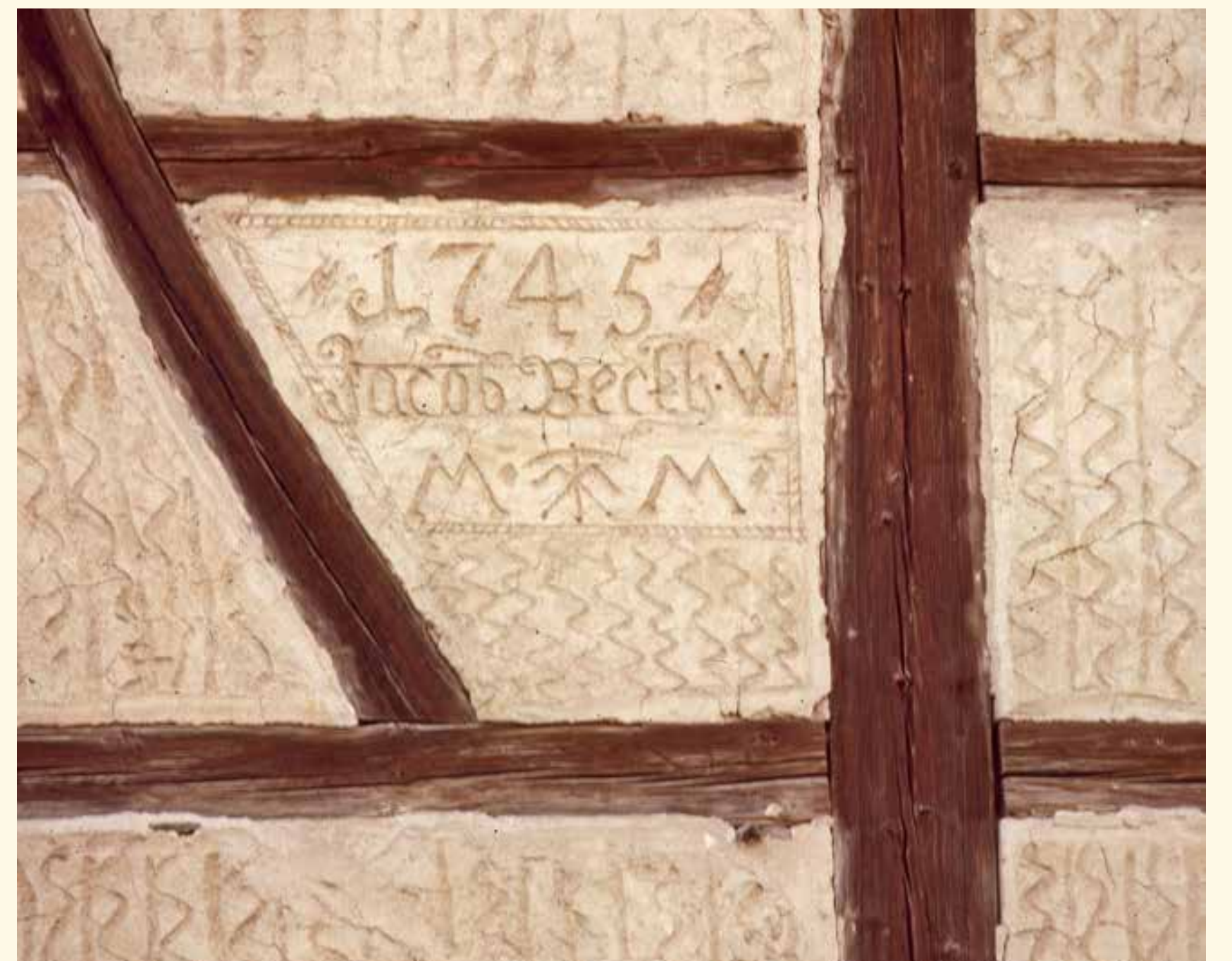
Scheune Vohl, Einritzungen im Fachwerk von 1745, Aufnahme 1971
