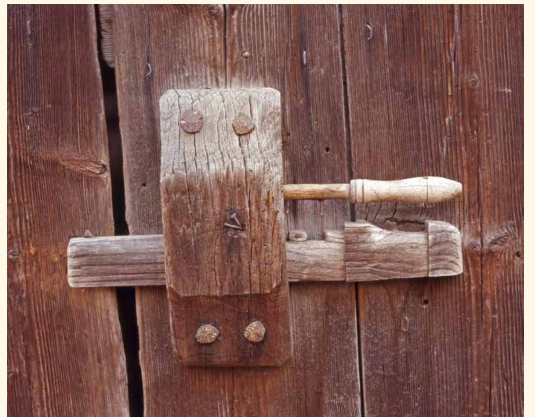
Scheune Vohl, Verschlussriegel der Scheuer, Aufnahme 1971
