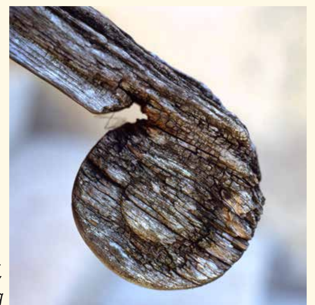
Handlauf, Abschluss am Treppenaufgang
