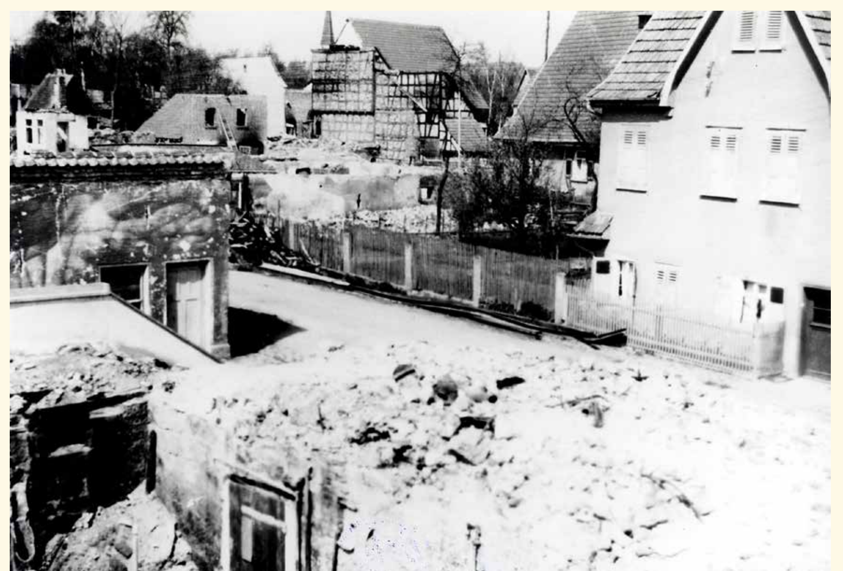
Ein Blick in die heutige Lengenfeldstraße nach dem Luftangriff vom 15./16. März 1944. Damals wurden in Leinfelden 68 Wohnhäuser, 68 Scheuern und fünf öffentliche Gebäude zerstört. Darunter auch das alte Rathaus mit dem Gemeindearchiv (s. Mitte des Fotos)
