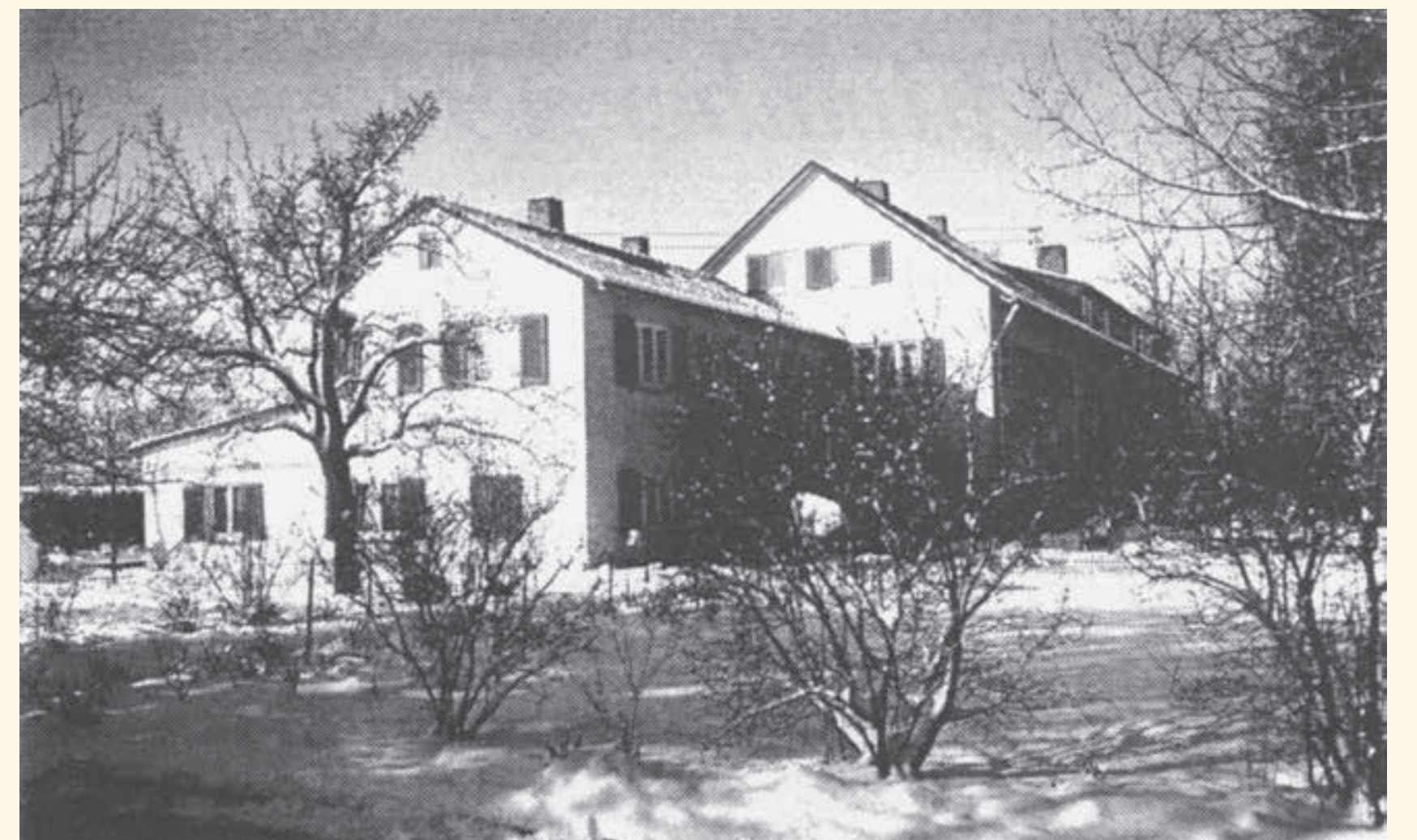
Haus AGAPE, Erweiterung 1960 und 1977
