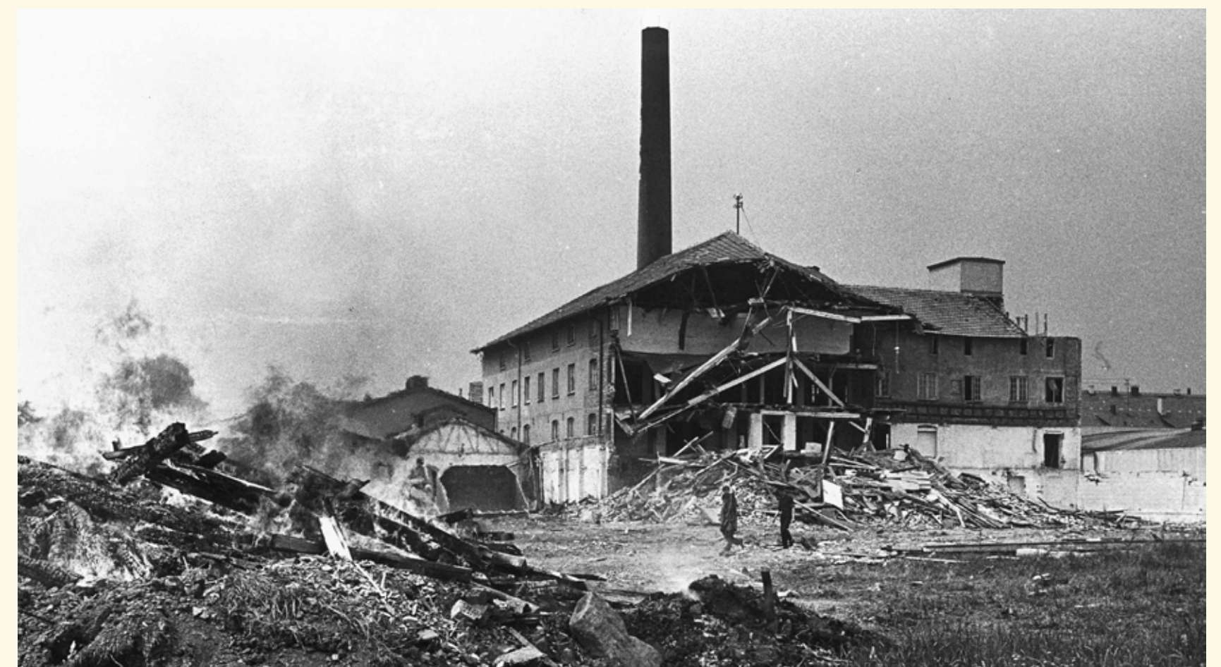
Abbruch der alten Ziegeleigebäude im Juni 1970
