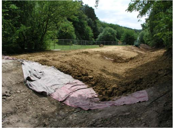
Einarbeiten des Vlieses und des Lehmschlags im Sommer 2011
