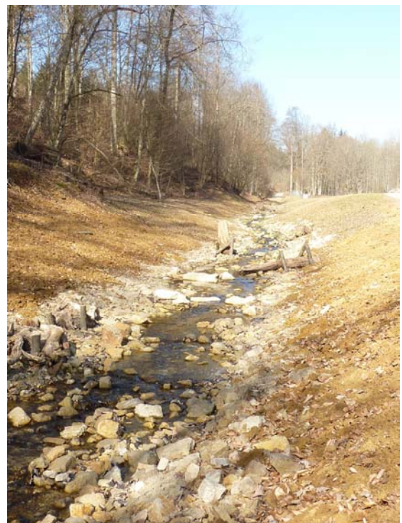
Das neue Bachbett wenige Wochen nach Inbetriebnahme, März 2012
