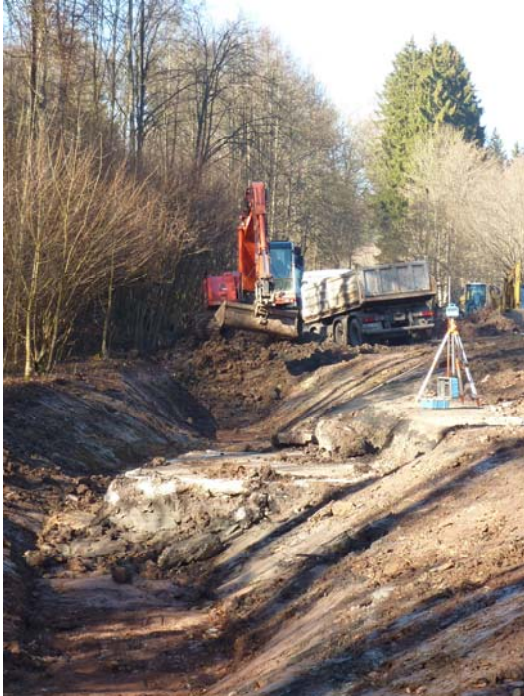
Geländeabtrag für das neue Bachbett und Entfernung alter Betonfundamente, Februar 2011
