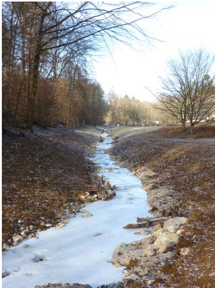
Dasselbe Gelände nach Herstellung des neuen Bachbetts Januar 2012
