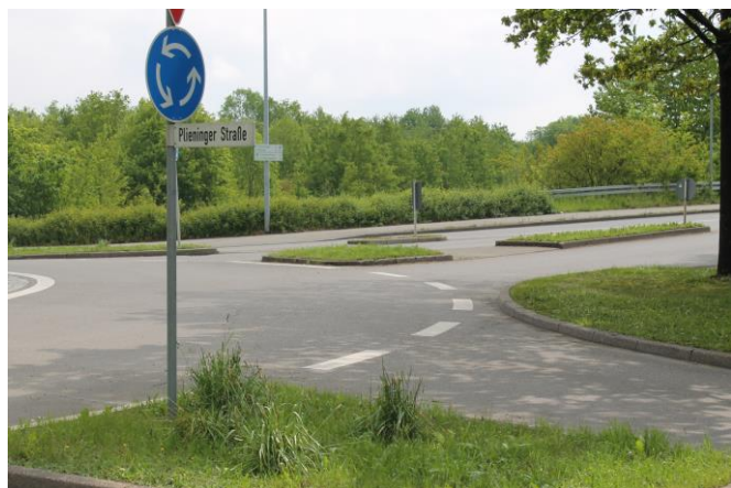
Abbildung 5: Östlicher Kreisverkehrsarm am Kreisverkehr mit Fahrbahnteiler
